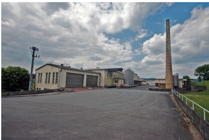
Vue du Sud-Est, WW+, 05.2008
