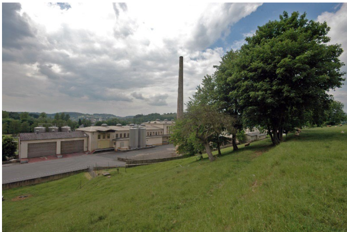
Vue du Nord-Est, WW+, 05.2008
