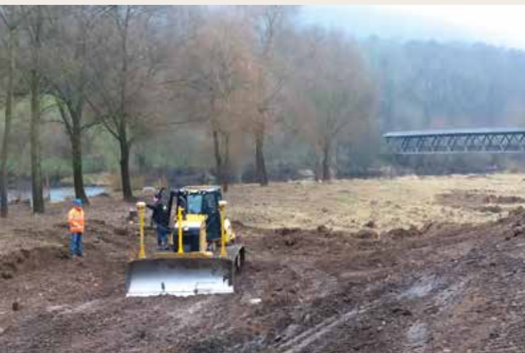
Im Februar 2017 wurden 15000 Kubikmeter angeschwemmte Sedimente am Ufer der Sauer abgetragen.
