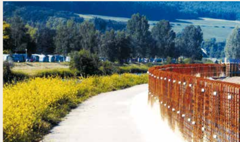
Eine Eisenkonstruktion, umhüllt von einem Mantel aus Beton, bildet die Schutzmauer entlang der rue de la Sûre, die - nach den erforderlichen Ausgleichmaßnahmen - zwischen 2001 und 2003 gebaut wurde.
