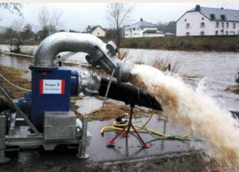
Eine der acht Pumpen, die bei Hochwasser zum Einsatz kommen.
