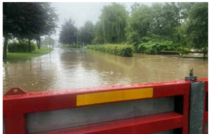
Mobile Elemente schützen die Ortschaft zusätzlich, sowohl auf der Mauer als auch am Eingang der Rue de la Sûre aus der Richtung der Stadt Diekirch.
