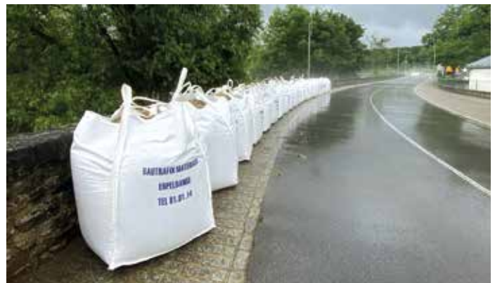
Diese tonnenschweren Säcke sichern die Mauer am westlichen Eingang von Ingeldorf.
