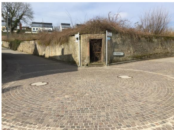
Mur, rues an der Hielt / Buerdenerhals
