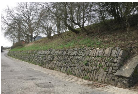
Mur, rue Buerdenerhals
