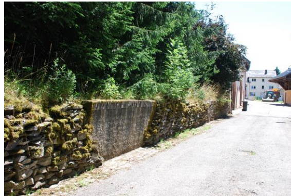
Murs, rue du Moulin
