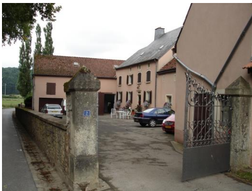
2, rue du Château + mur d'enceinte
