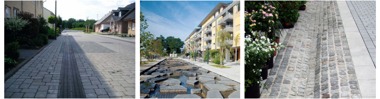
Abb.115: Beispiele für offene, oberirdische Entwässerungsprinzipien, die das Erscheinungsbild prägen und somit die Auseinandersetzung mit deren Gestaltung erfordern
