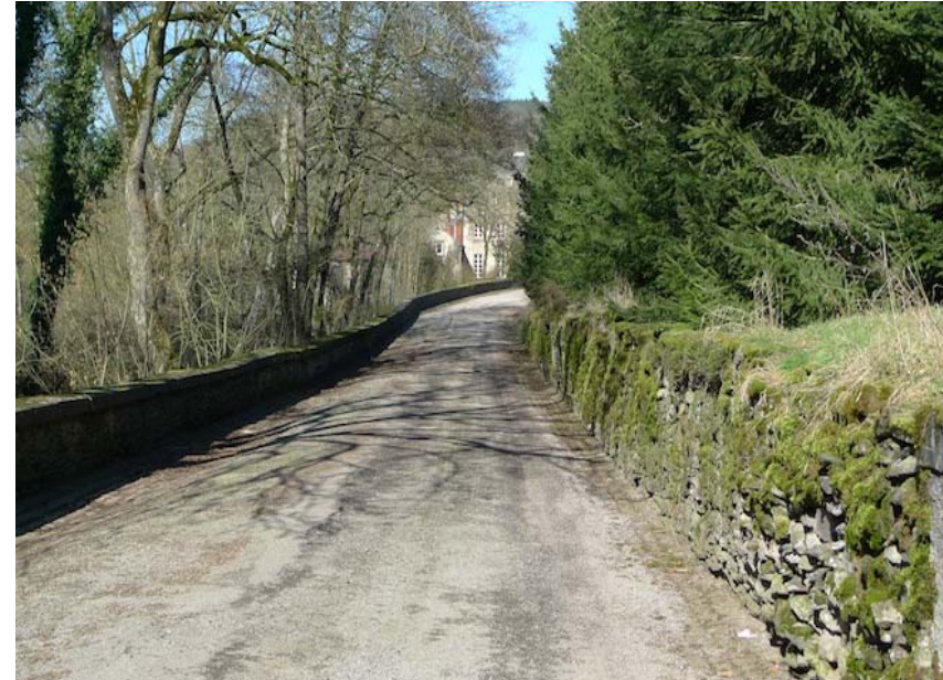
(1) Blick nach Norden Trockenmauer an der westlichen Grenze der Fläche
